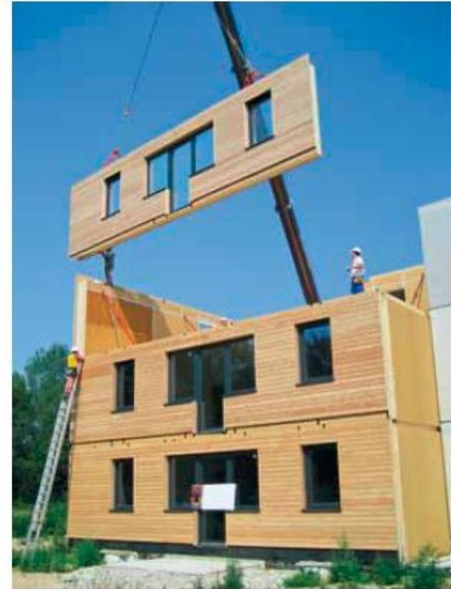
Abb.1.1.6 Montage Großtafelbau
