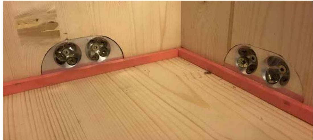
Befestigung mit SHERPA CLT-Connector
